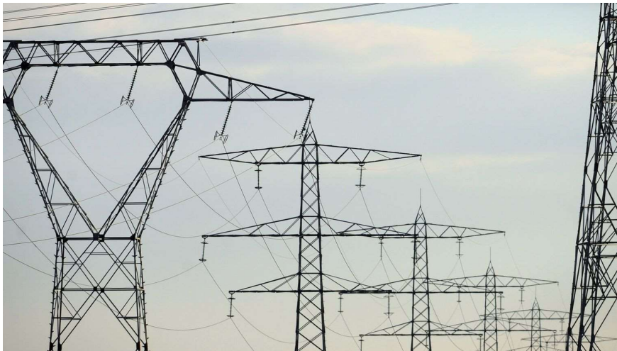
Fig 3.a : des pylônes métalliques
